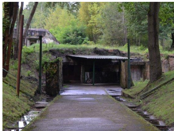
Ukryte wejście do bunkra Zeppelin. Stan obecny
